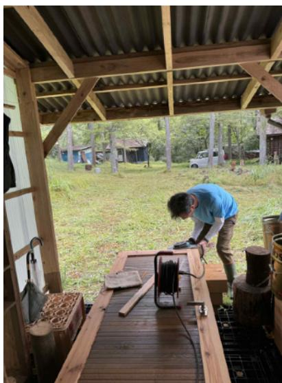
所で削ります。電動鉋を使いました。削りは上手くいったので次は取り付け作業。楔を二つ作ってドアの下に差し込み、ドアが真っ直ぐなるように調整しながら、ネジで固定します。このアイデアは成功でした。
